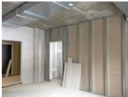
Der Innenausbau wird weitestgehend in Trockenbau ausgeführt. Diese Bauweise ermöglicht einen sehr schnellen Baufortschritt und eine hohe Flexibilität bei eventuellen späteren Umbauten.
