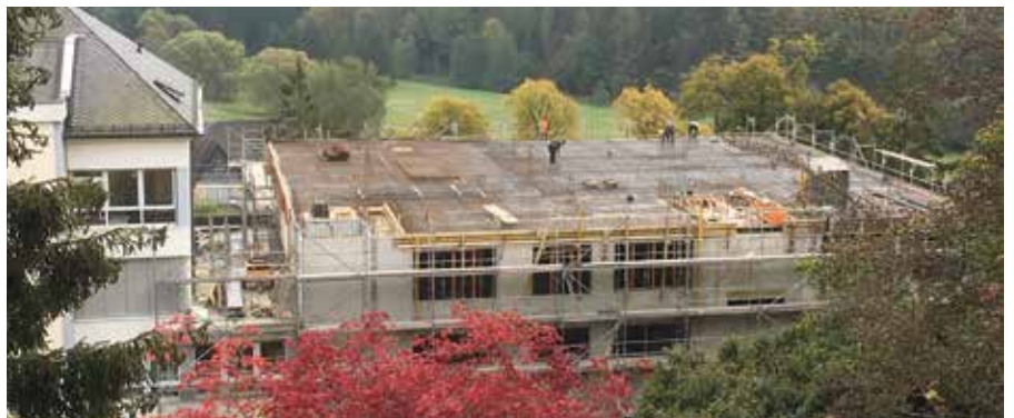
Blick auf das 2.OG Intensivstation: Die geräumigen Intensivzimmer von teilweise über 33m 2 bieten zukünftig viel Platz für eine professionelle und zukunftsorientierte Patientenversorgung.
