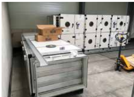
Auch in der Technikzentrale im 4.OG wurde fleißig gearbeitet. Zukünftig werden dort ca. 14.000m³ Luft in der Stunde umgewälzt. Durch hoch effiziente Wärmerückgewinnung wird nicht nur in der Intensivstation und der Radiologie für angenehmes Raumklima gesorgt, sondern auch für die Patientenzimmer im 1.OG.
