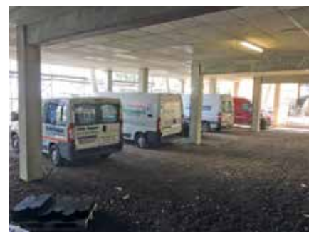
Zur Entspannung der Parkplatzsituation wurde unterhalb des Gebäudes Lava verdichtet, um provisorische Parkplätze für die Baufahrzeuge herzustellen. Leider wird sich die Gesamtsituation erst Ende des Jahres entspannen.
