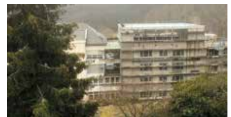
4. OG Technikzentrale: Die letzten Anschlussarbeiten an den Bestand sind am Laufen, und das Dach ist auch schon weitestgehend abgedichtet.
