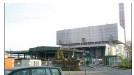
Ansicht des Müllheizkraftwerks in Bonn. SWB= Stadtwerke Bonn.
