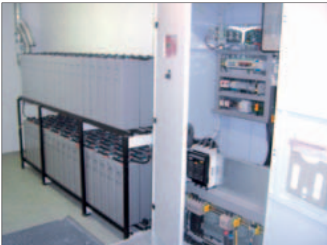
Akkuzellen mit Schaltanlage
