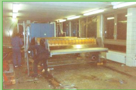
Abbau der alten Heißmangel
