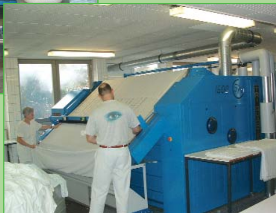
Die Wäsche wird der neuen Heißmangel zugeführt
